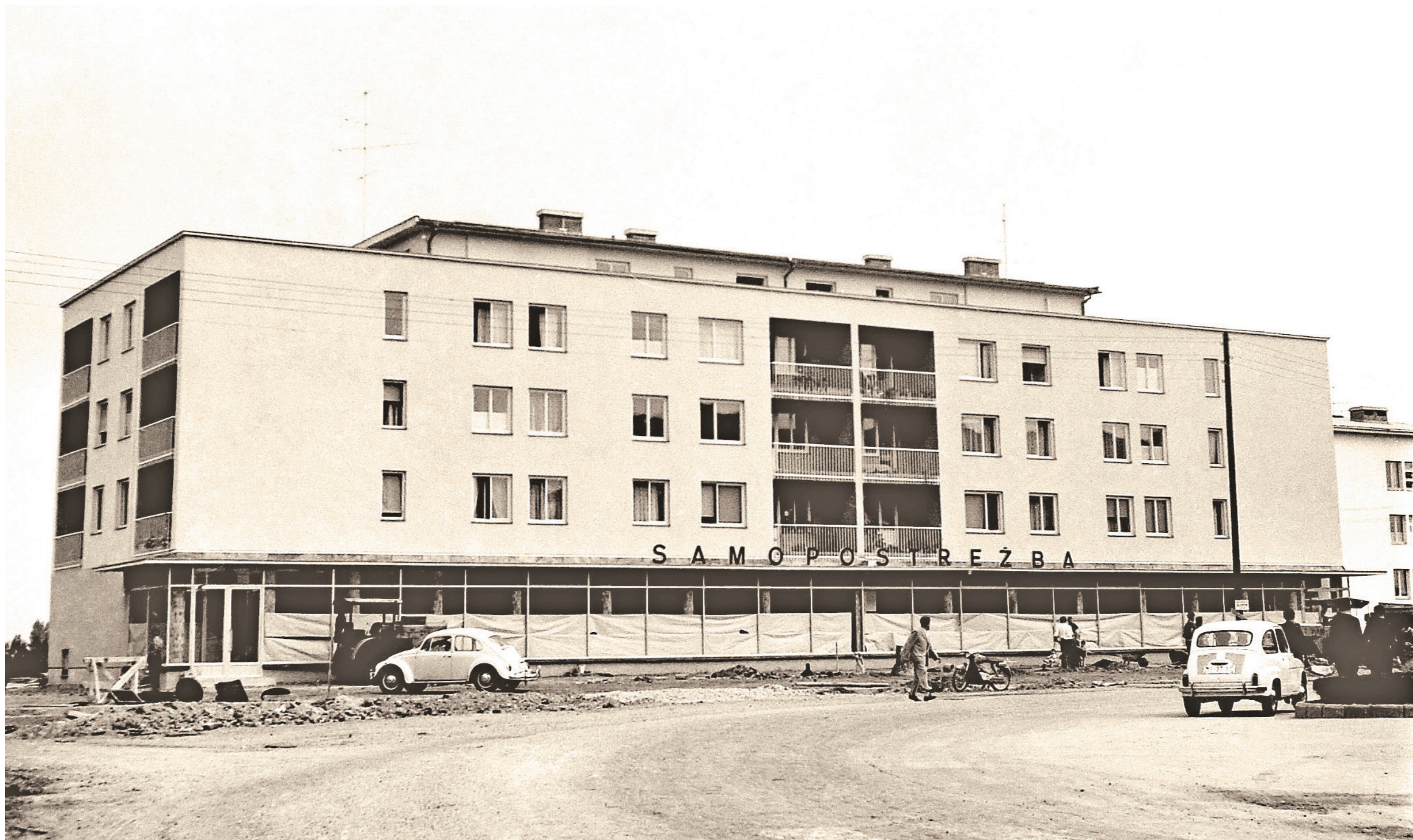
Gradnja samopostrežne trgovine v Lendavi okoli leta 1965. / Az önkiszolgáló bolt építése Lendván 1965 körül.
