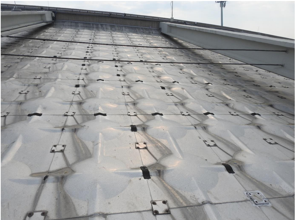
Slika 16: Prikaz dodatno nameščenih trakov na osnovi bitumna, ki so bila vgrajena v sklopu poskusa zatesnitve netesnih mest pločevinaste strehe (prikaz mest le na enem odseku strehe)
