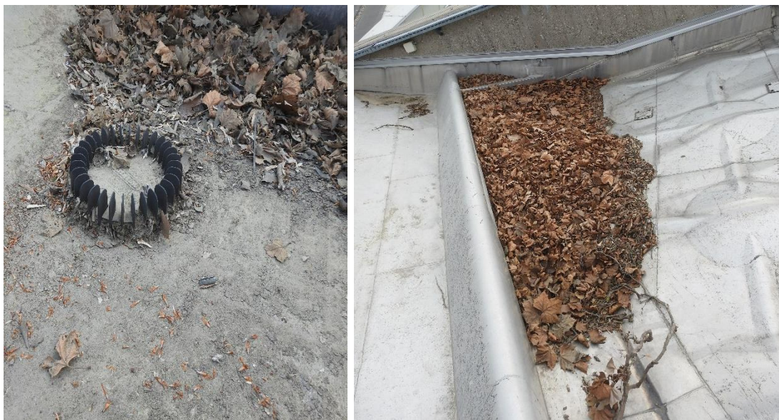
Slika 4: Pogled na nečistoče v predelu S (leva slika) vtočnika in J (desna slika) vtočnika
