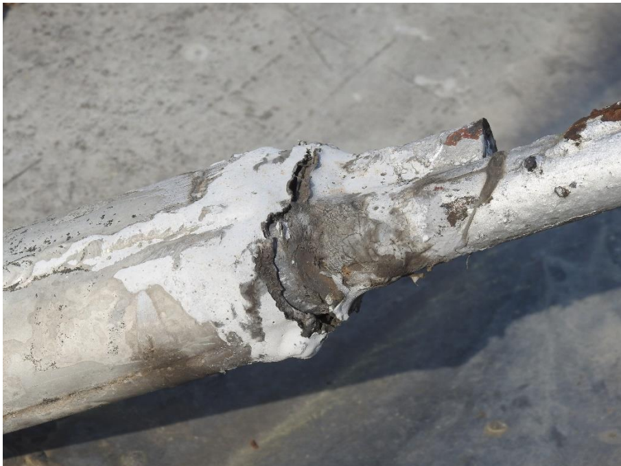
Slika 12: Prikaz odpiranja stika v predelu stika zatega in pločevinaste kritine strehe
