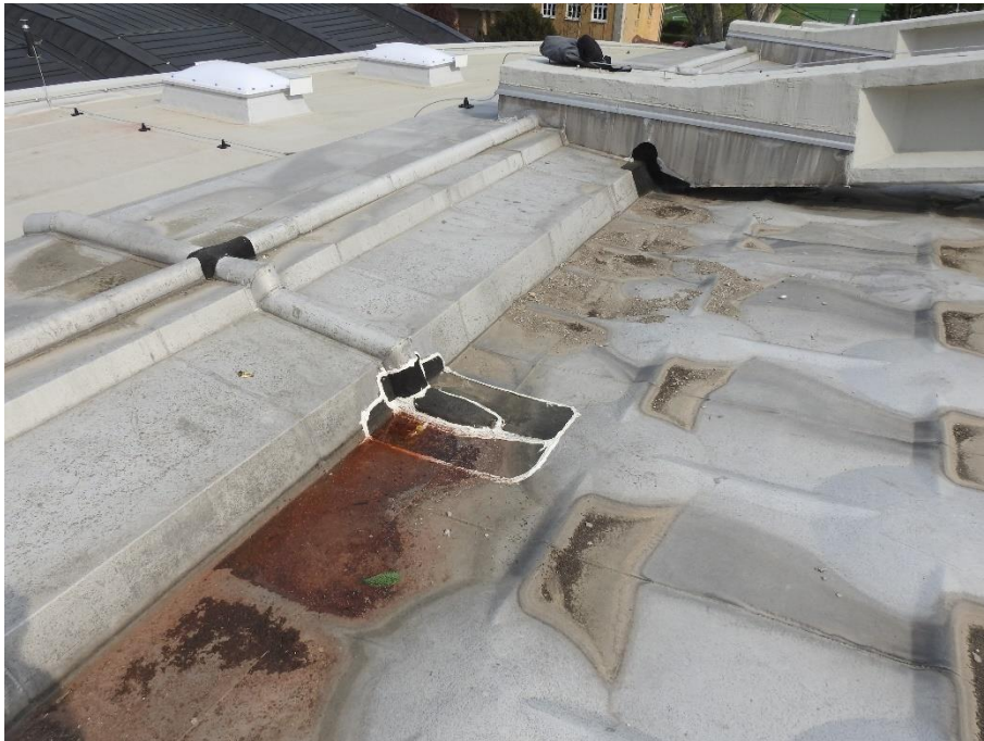
Slika 23: Prikaz lokalnega zastajanja meteorne vode, v osrednjem delu strehe tribune, ob spodnjem robu (zahodna stran tribune)
