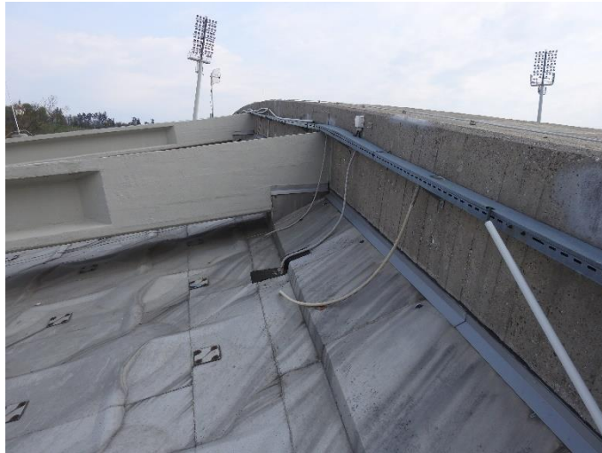
Slika 8: Prikaz pogleda na elektro cevi ob glavnem a.b. loku tribune
