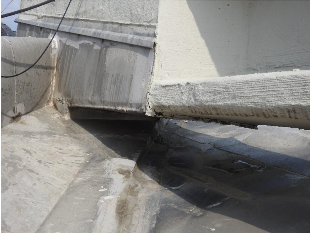
Slika 13: Prikaz pogleda na stik med a.b. nosilcem in pločevinasto kritino strehe
