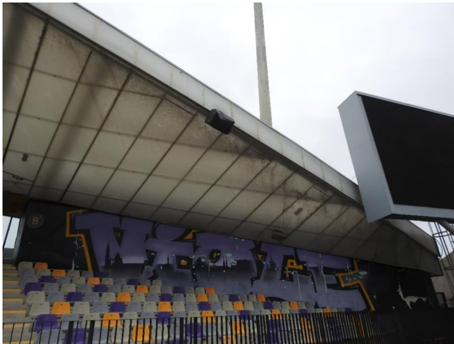
Slika 14: Prikaz na sledi umazanije in precejanja vode na zgornji površini spodnjega sloja transparentnih plošč
