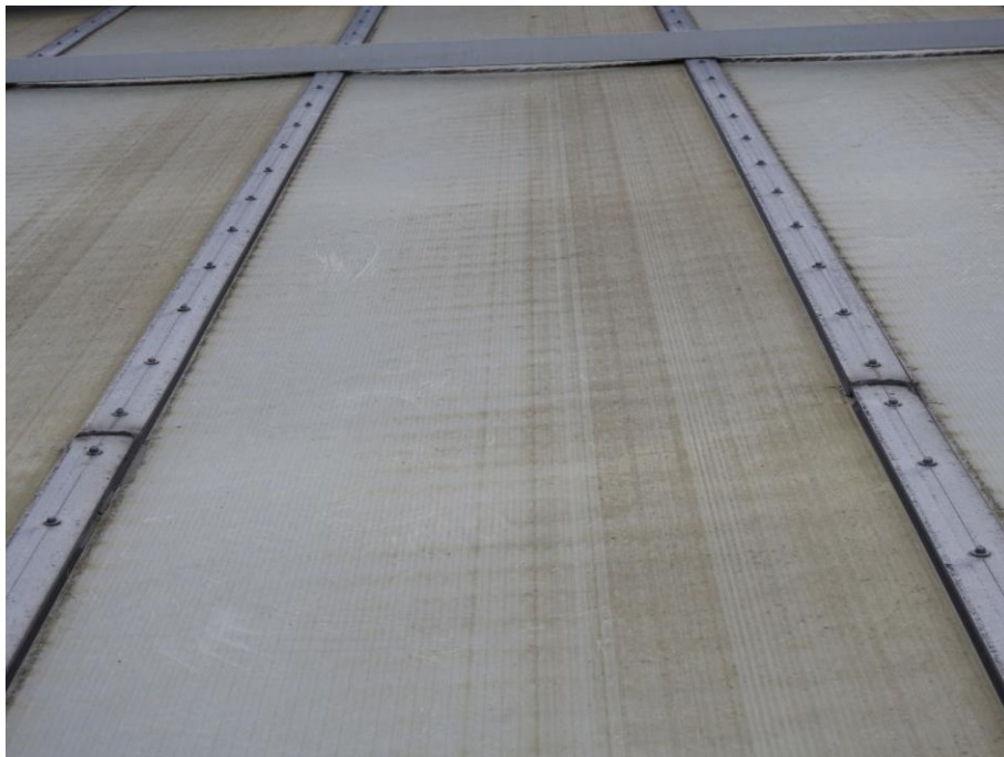
Slika 23: Prikaz deformacije oz. povese Lexan plošč
