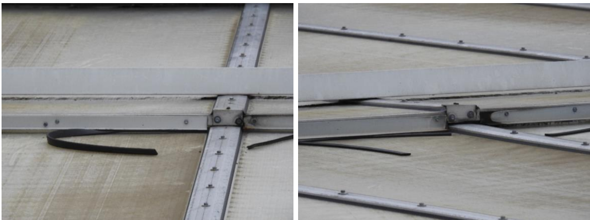
Slika 31: Prikaz pogleda na izpadli del EPDM tesnilnega traku v predelu prečnega stika dveh vzdolžnih transparentnih plošč
