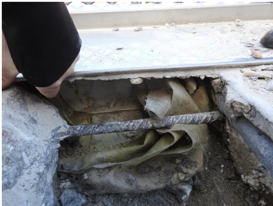
Slika 58: Prikaz pogleda izveden vertikalnega zavihka HI FPO folije
