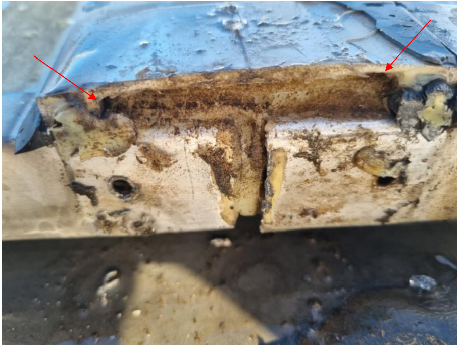
Slika 42: Prikaz sledi precejjanja vlage in umazanije v zaledje ALU profila (v levem in desnem zgornjem vogalu je prisotna tudi manjša odprtina)
