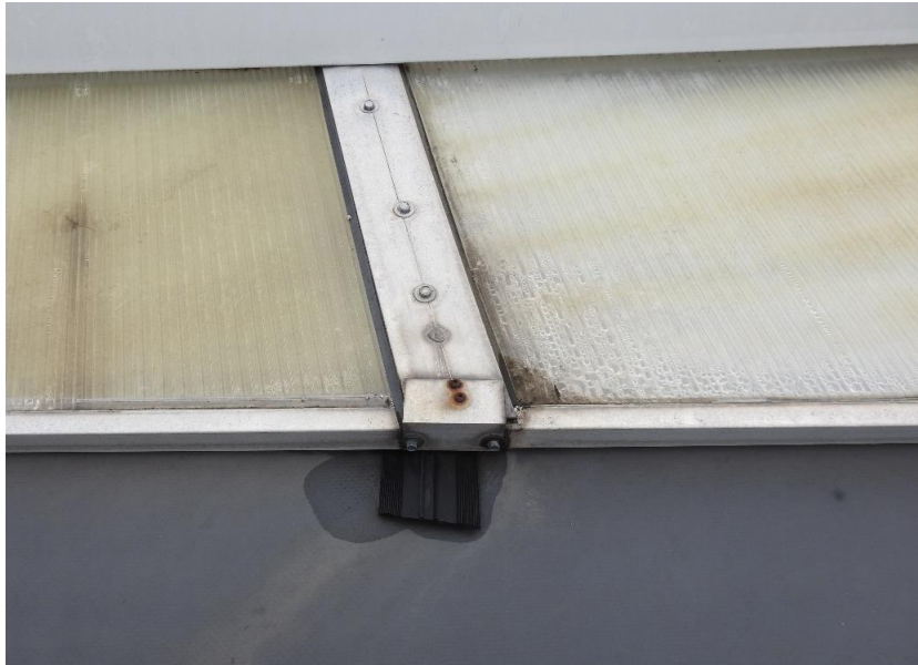
Slika 32: Prikaz na zamik gumiranega tesnila ALU profila kot je to bilo ugotovljeno na več mestih
