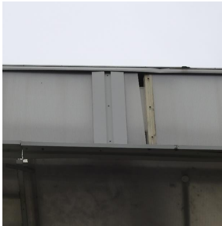
Slika 16: Prikaz zamika oz. odprtega predela v čelu transparentne kritine, v predelu poteka dilatacije objekta nad J tribuno
