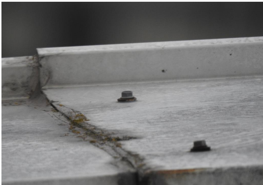
Slika 35: Prikaz netesnega stika pločevinaste kape ob robu transparentne strehe (predel proti igrišču)
