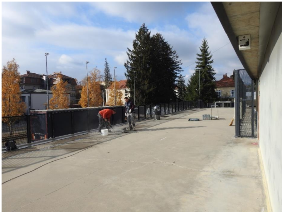
Slika 45: Prikaz pogleda na mesto sondažnega izseka z oznako S2
