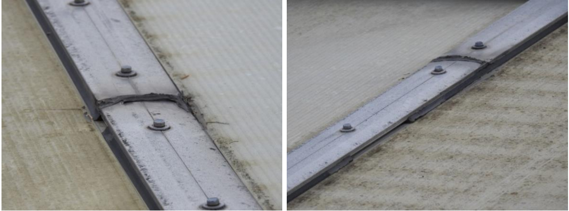
Slika 26: Prikaz lokalne netesnosti stika v predelu ALU profila, kot je to evidentirano na več mestih predmetne strehe
