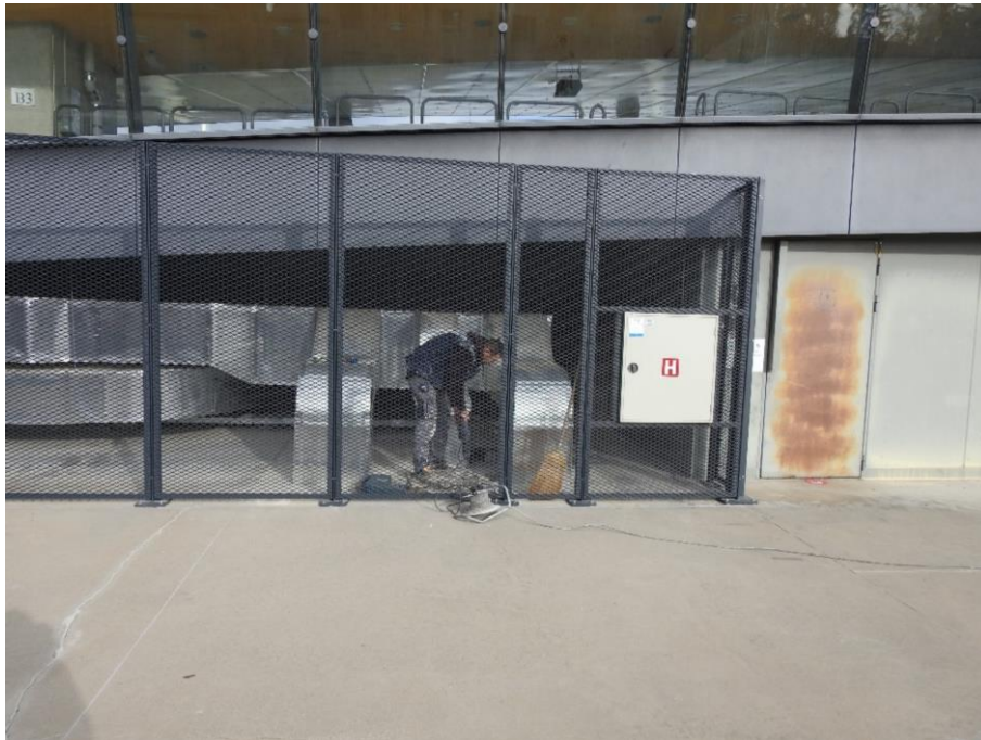
Slika 52: Prikaz pogleda na mesto sondažnega izseka z oznako S4
