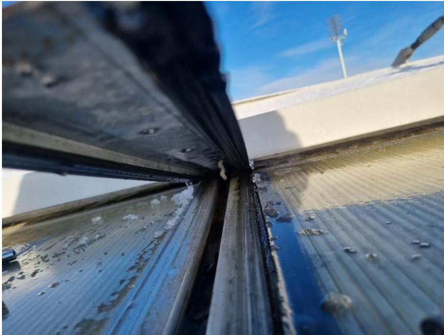
Slika 44: Prikaz pogleda na tesnilo zgornjega ALU profila in sledi precejanja vode mimo predmetenga tesnila v zaledje profila
