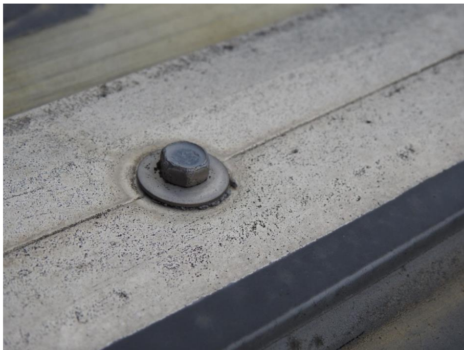
Slika 25: Prikaz dotrajanosti tesnilne gumice vijaka
