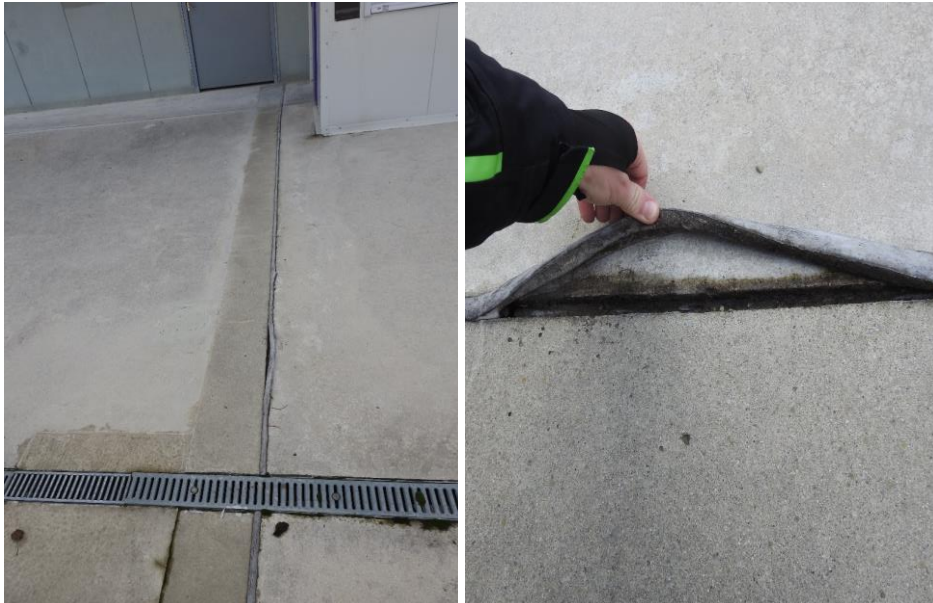
Slika 10: Prikaz izpadanja tesnilne mase v predelu prostorske dilatacije
