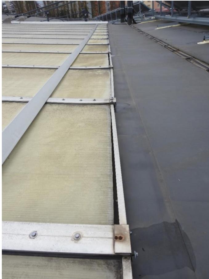
Slika 28: Prikaz zamika oz. odpiranje stika v predelu spodnjega dela transparentne kritine
