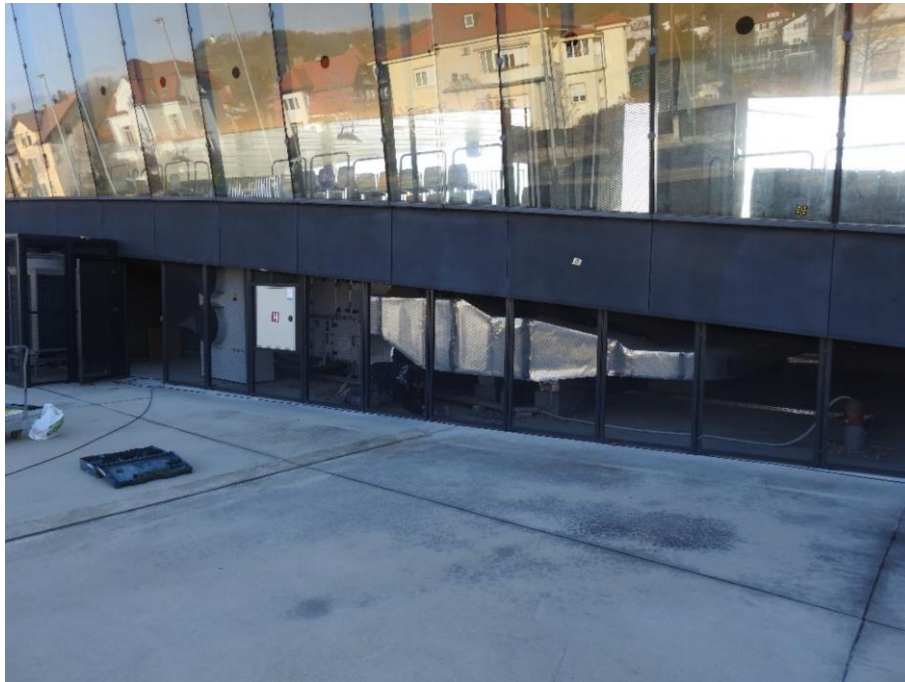
Slika 59: Prikaz pogleda na mesto sondažnega izseka z oznako S6
