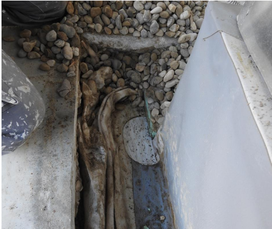
Slika 60: Prikaz izvedenega vertikalnega zavihka FPO folije
