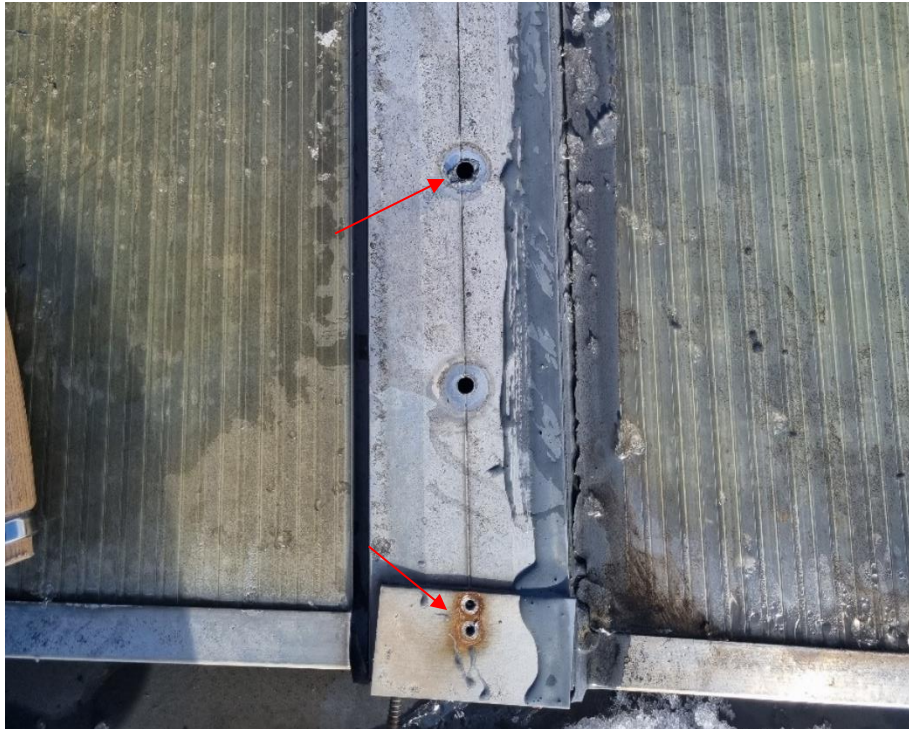
Slika 40: Prikaz pogleda na stanje po odstranitvi zgornjih vijakov ALU profila
