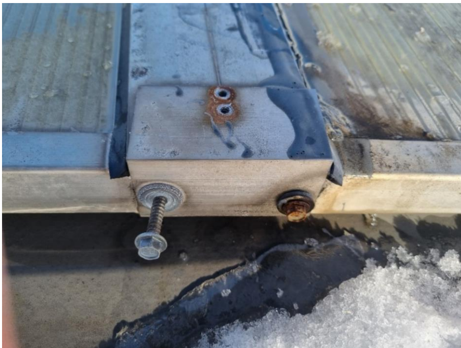
Slika 41: Prikaz pogleda dotrajano tesnilo bočnega vijaka za pritrdjevanje ALU kotnega profila
