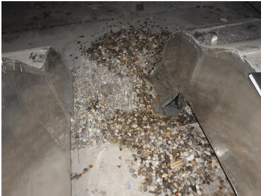
Slika 48: Prikaz pogleda na mesto sondažnega izseka z oznako S3
