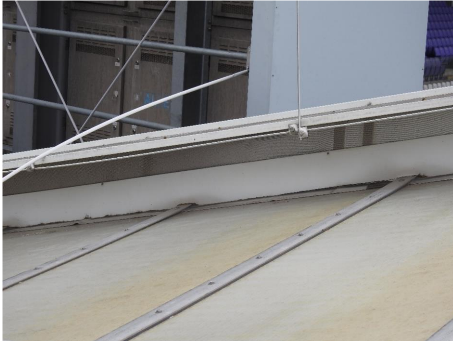
Slika 34: Prikaz pogleda na izvedbo prezračevanja v predelu zgornjega roba transparentne strehe
