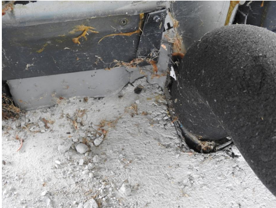
Slika 55: Prikaz netesnosti stika v predelu cevnega preboja
