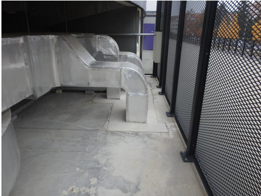
Slika 6: Prikaz pogleda na enega izmed prebojev plošče nad pritličjem
