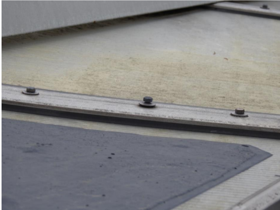
Slika 24: Prikaz primera nezadostno privijačenega vijaka
