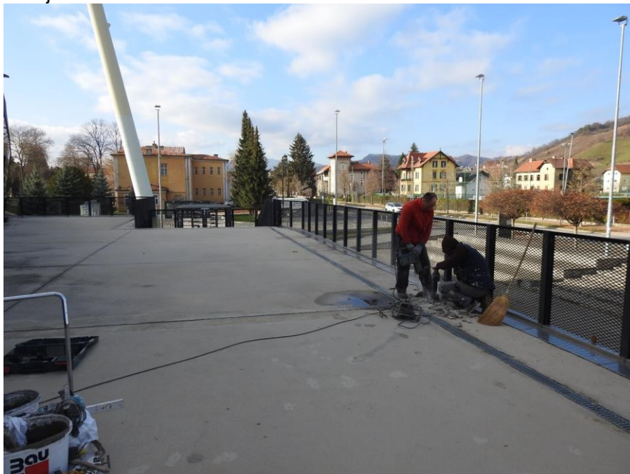
Slika 56: Prikaz pogleda na mesto sondažnega izseka z oznako S5
