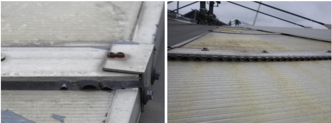
Slika 27: Prikaz lokalne grbančenja tesnilne gumice ALU profila
