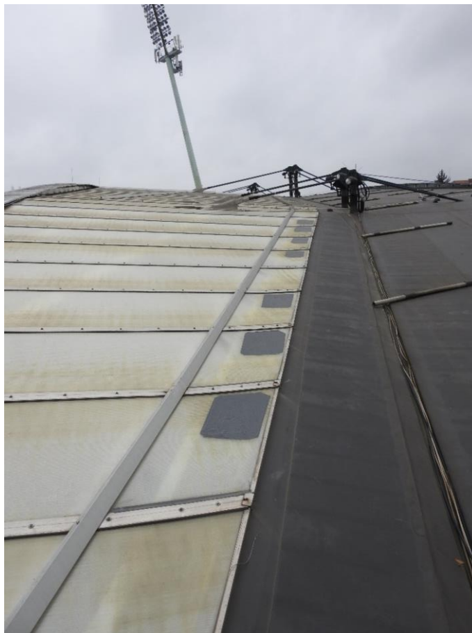
Slika 21: Prikaz sledi izpostavljenosti Lexan plošč vsem vremenskim vplivom in območja kjer se je v preteklosti že izvajalo dodatno tesnjenje s tekočo membrano
